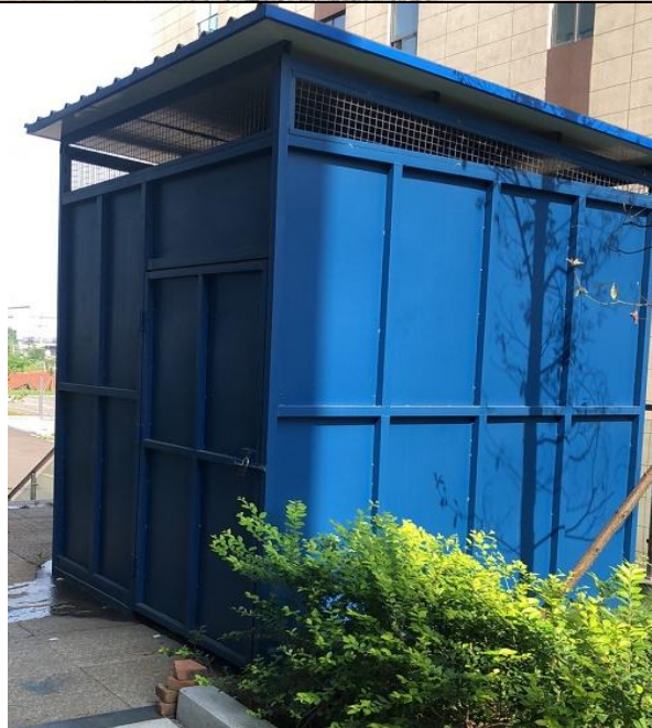
垃圾车及固废暂存间（面积 5m 2 ）
